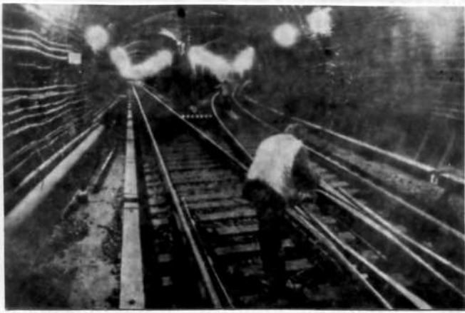
Накануне пуска. Тоннели у "Петровско-Разумовской".
