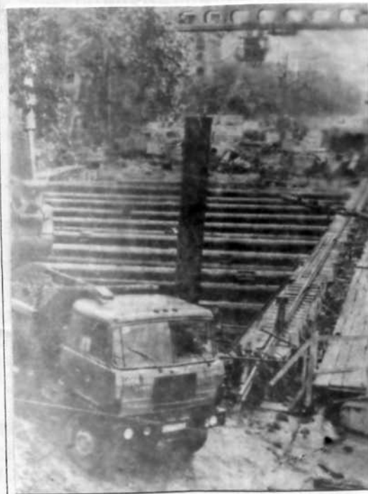
Строительство станции "Дмитровская".
