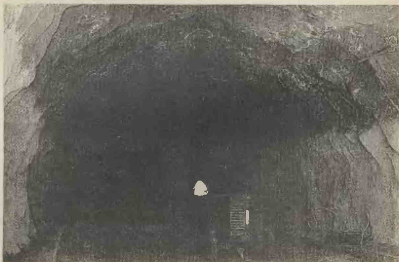
Рис. 3. Тоннель на Военно-Грузинской дороге с обделкой из набрызгбетона.
