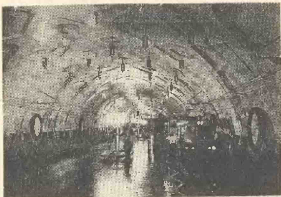
Станция «Проспект металлургов».
