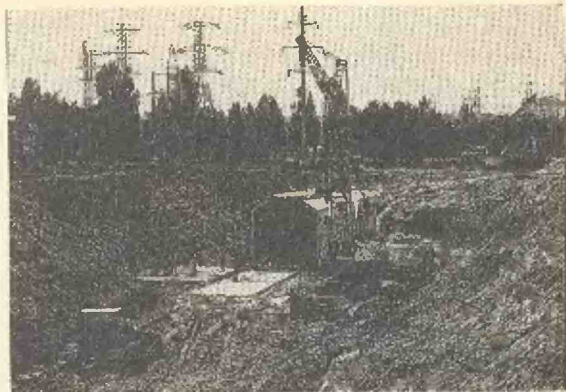
Сооружение перегонных тоннелей «Камвольная» — «Электрозаводская».
