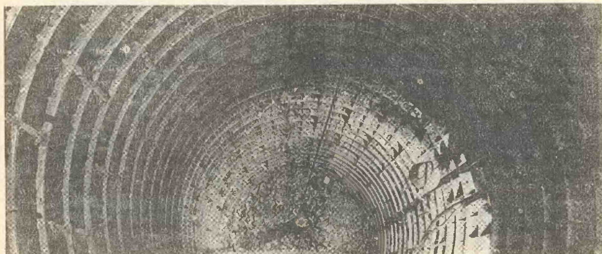
Сооружение ствола из чугунных трубчатых с резиновыми прокладками на станции «Марьино роща» в Москве.
