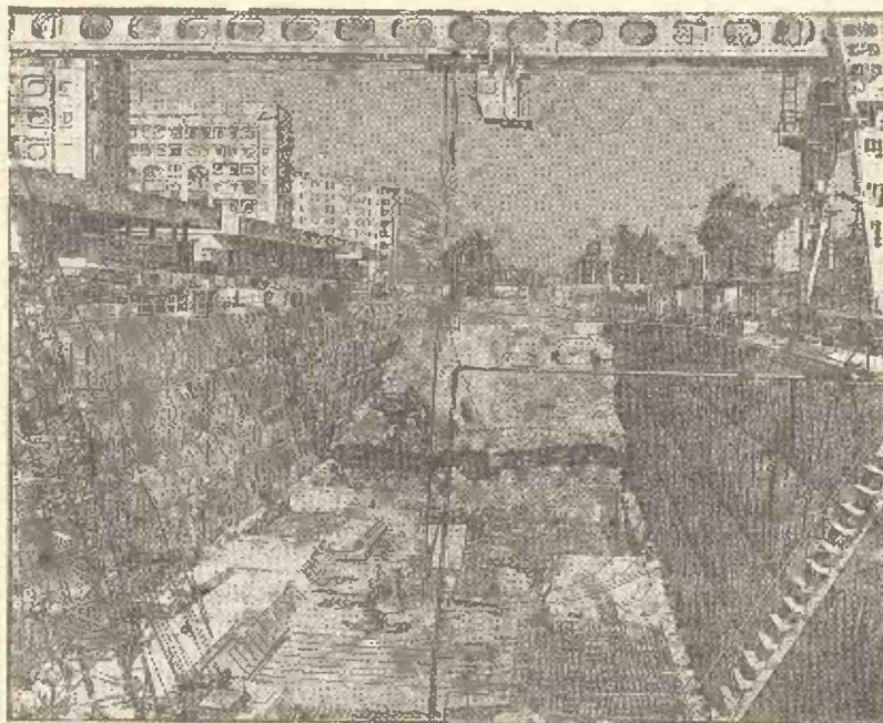
Нагельное крепление бортов котлована станции «Тинчлик».
