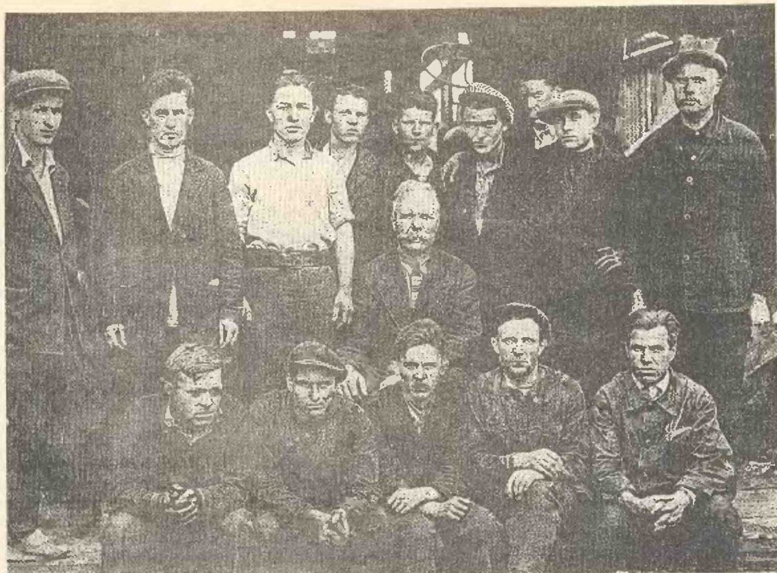
Бригада, участвовавшая в монтаже английского щита «Грэйтхэд» на 12 шахте («Комсомольская»). Снимок 1933 г.
