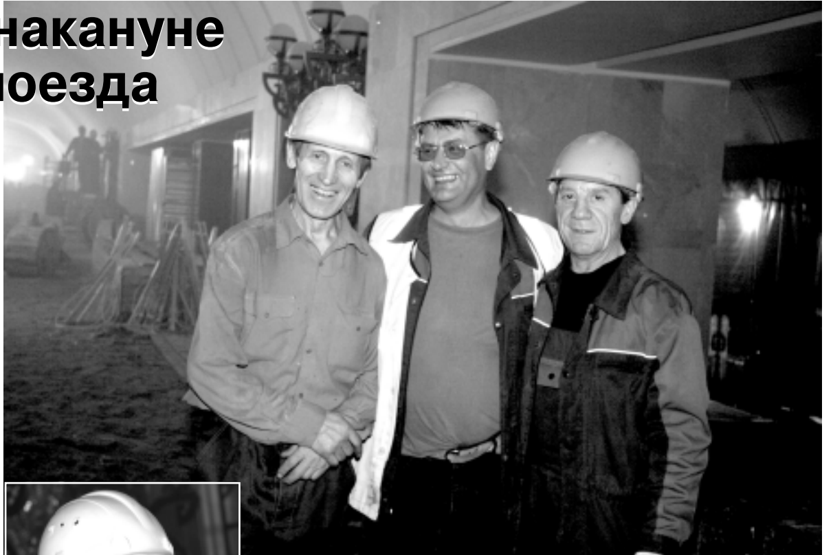
Электромонтажники СМУ-4 Б.И. Гусев, М.В. Решетников, В.Б. Почуев.
