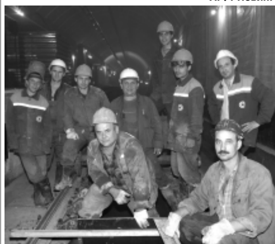
Начальник участка СМУ-8 С.В. Мерзликин (в белой каске справа) с проходчиками, выполняющими профилировку лотка в правом станционном тоннеле.
