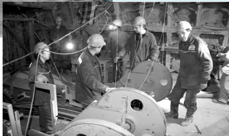
Пересадка на «Тургеневскую». Эскалаторщики участка Д.В. Колесова перед навешиванием цепей.
