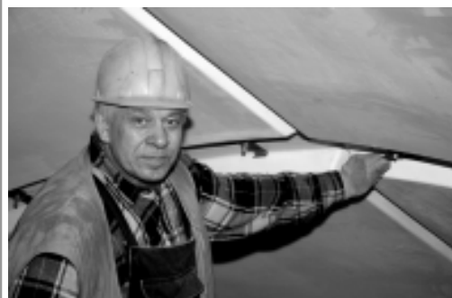
Слесарь С.А. Колесов из УСР монтирует зонт над наклоном, ведущим к «Чистым прудам».
