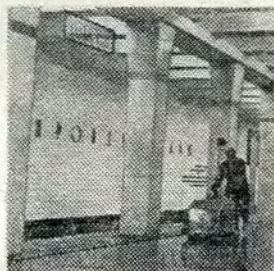
Идут путевые работы, мойка и уборка вагонов платформы.
