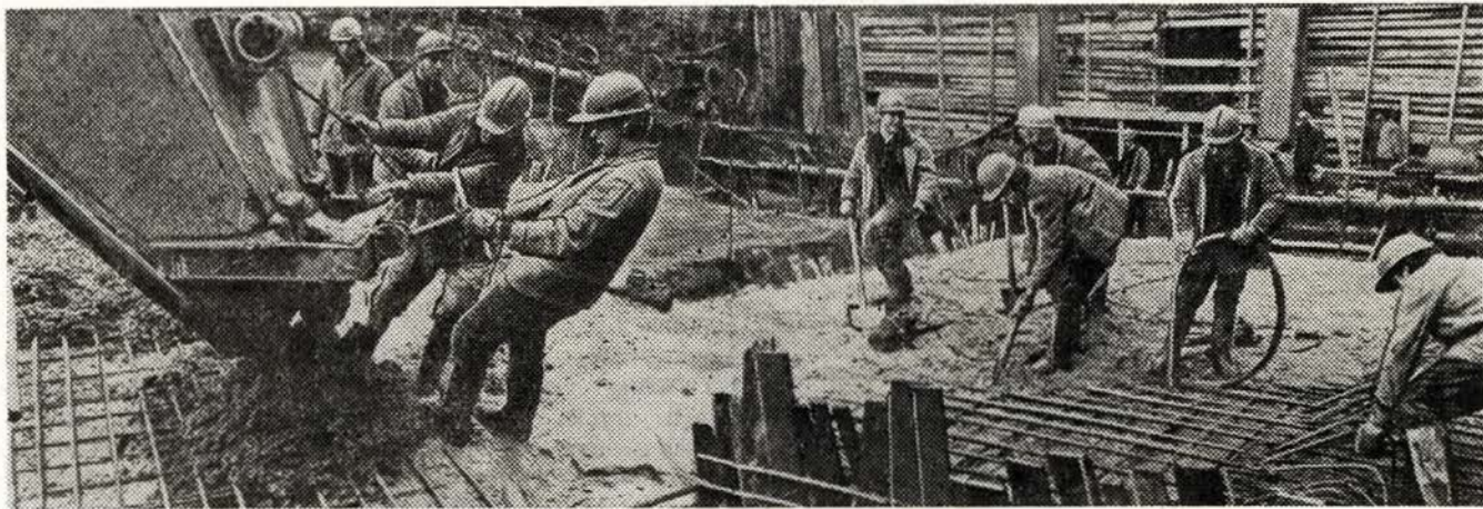
На снимках: Бригада штукатуров монтеры спецработ А. Парамоновой (вверху справа). Монтажные работы на Центральном пересадочном узле (слева) Комсомольско-молодежная бригада А. Федченко ведет бетонирование лотковой части станции «Тушинская» Краснопресненского района (нижний снимок)
