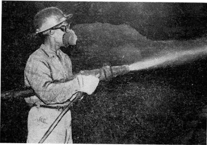
Рис. 2. Нанесение набрызг-бетона
