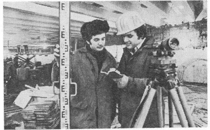
Сменные маркшейдеры Киевметростроя В. Колесник (на снимке — слева) и В. Коваль проверяют точность установки облицовки в подземном вестибюле станции «Площадь Калинина».
