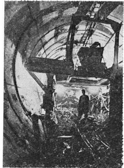
Сооружение правого перегонного тоннеля «Барекамутян» — «Киевлян»
