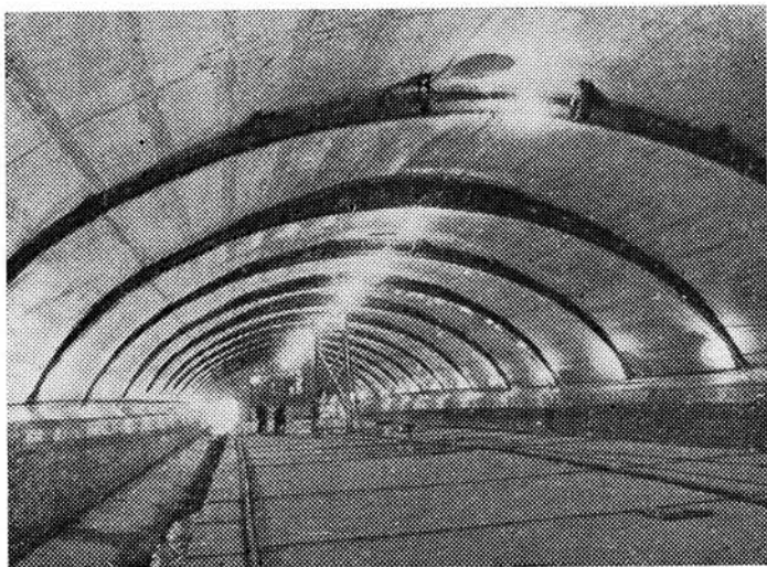
Строится станция «Тракторный завод»
