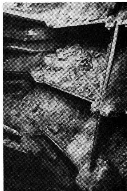
Рис. 4. Откосный забой мелкого песчаного грунта в головной части щита
