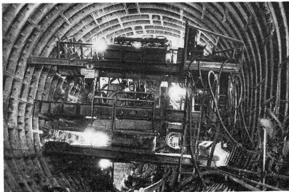
Тюбингоукладчик наклонного хода на станции «Марксистская».
