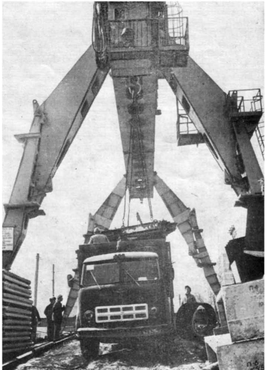
Калининский радиус. На станции «Новогиреево».
