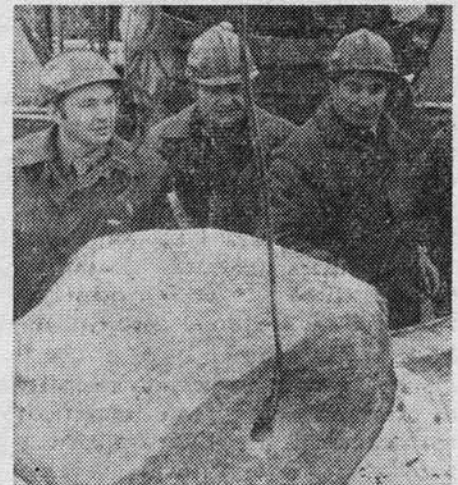
Валун, встреченный при проходке перегонного тоннеля
