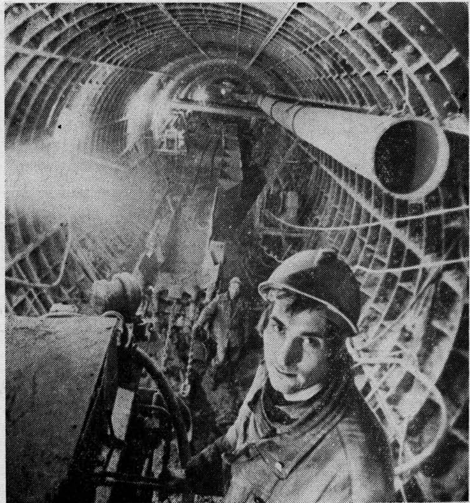
Строится Серпуховский радиус Московского метрополитена. На снимке: оператор горнопроходческого комплекса Н. ВЕДЮХИН.
