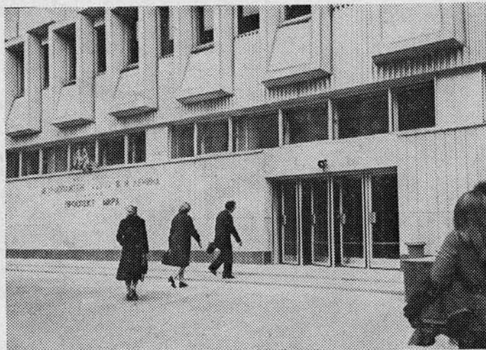
Новый вестибюль на станции «Проспект Мира» Калужско-Рижского диаметра Московского метрополитена. Встроенный в инженерный корпус станции, он имеет четыре выхода. В тамбурах для облицовки впервые применен гофрированный алюминий. Соорудил вестибюль коллектив СМУ № 2 Мосметростроя.
