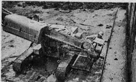
Бурение скважин под установку анкера станком фирмы «Бауэр».
