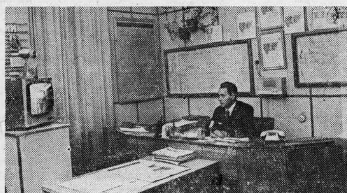
Центральный диспетчерский пункт эскалаторов. На Ленинградском метрополитене ведутся работы по оснащению линий промышленным телевидением.
