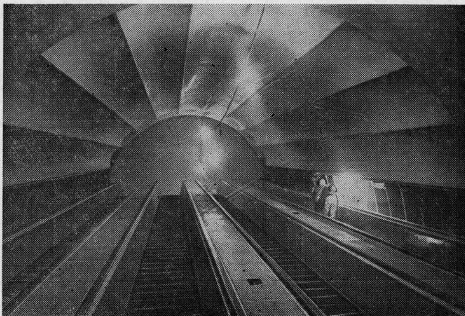
Рис. 1. Водозащитный зонт в пересадочном эскалаторном тоннеле станции «Марксистская».
