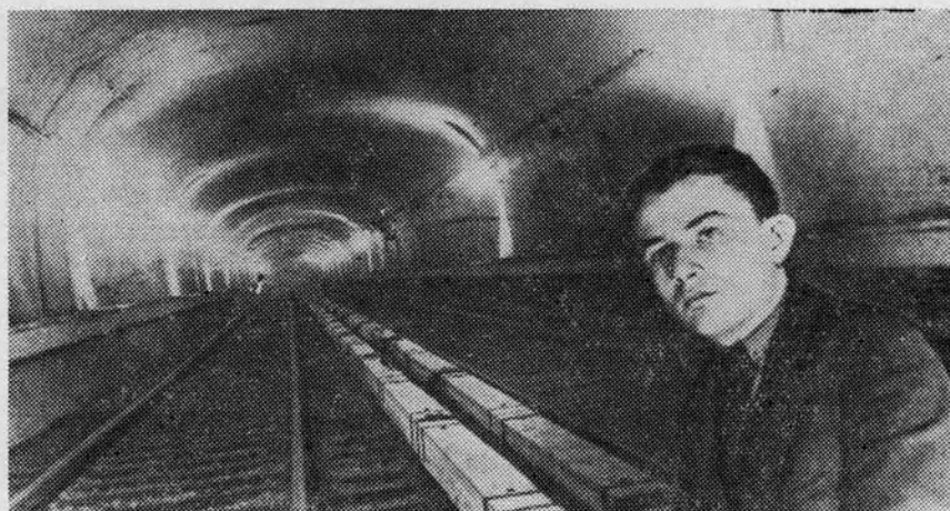
Рис. 8. Готовый тоннель и автор проекта производства строительных работ В. С. Пичуль
