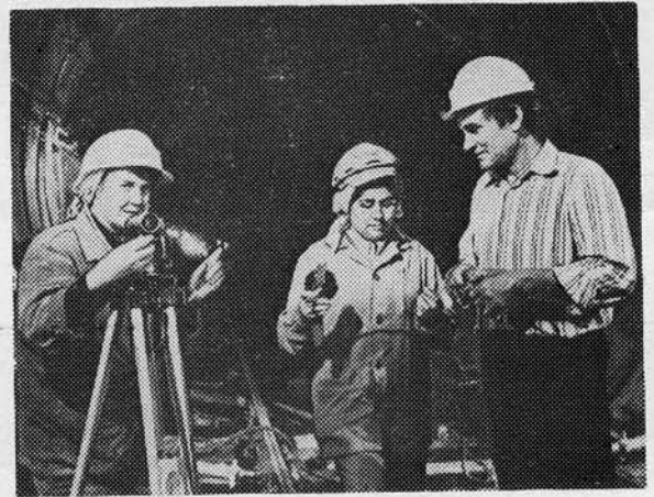
Маркшейдерский контроль на Ташметрострое.
