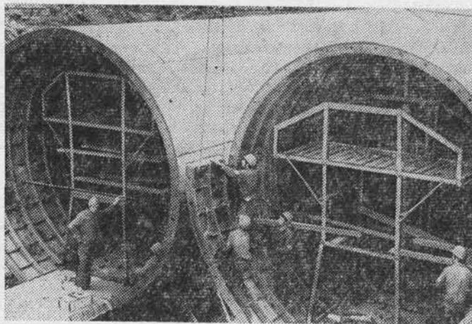
Перегонные тоннели у станции «Вокзальная».
