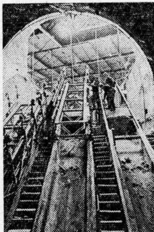
Монтаж эскалаторов.
