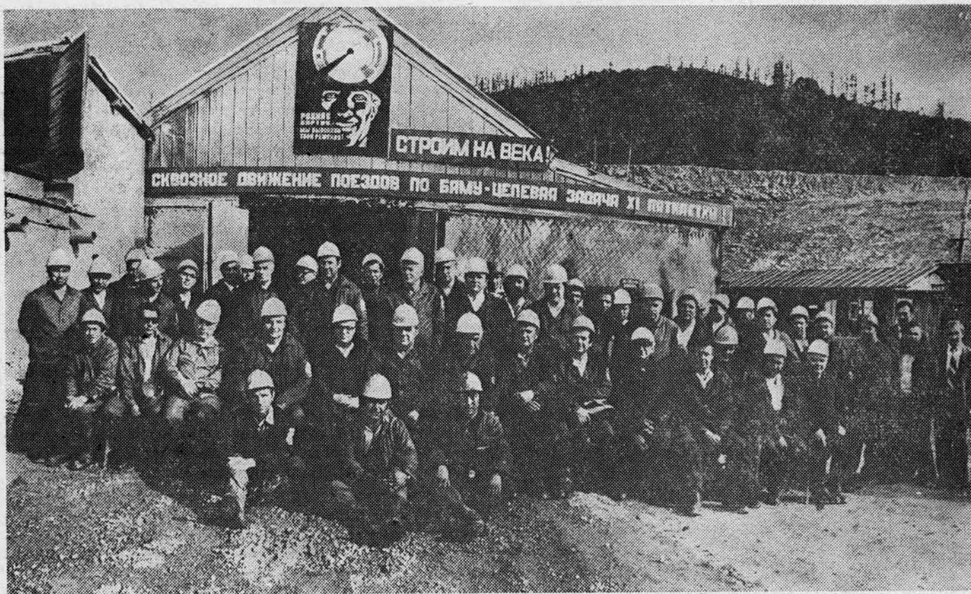
Участники семинара на Западном портале Северо-Муйского тоннеля
