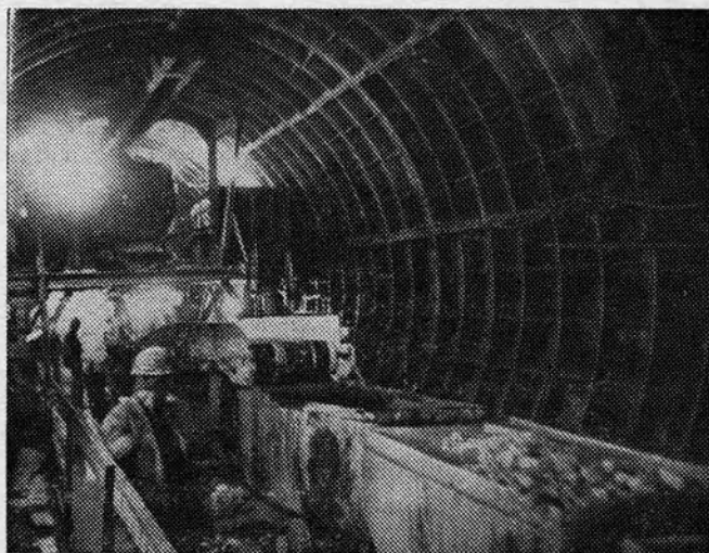
Строительство перегона в направлении к станции «Цветной бульвар» Московского метрополитена
